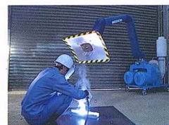
移動式集じん機の設置
